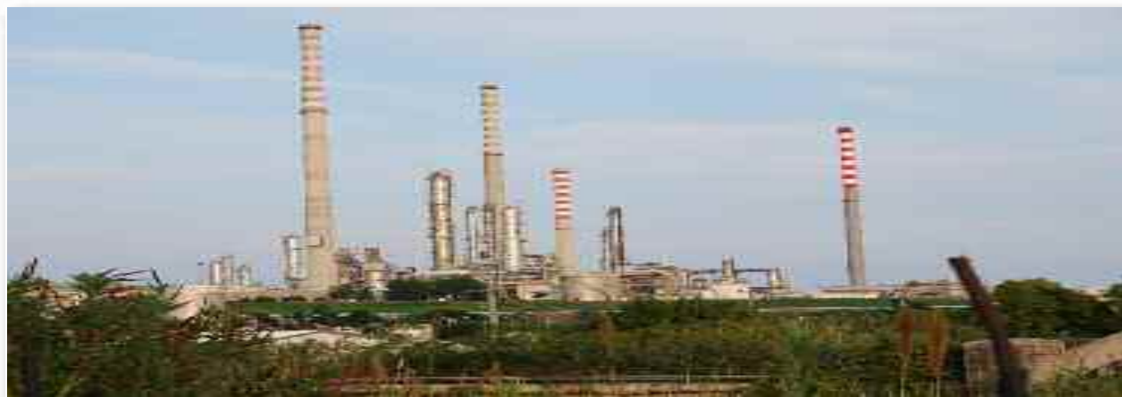
Qui sotto lo stabilimento Sasol Italy di Augusta
